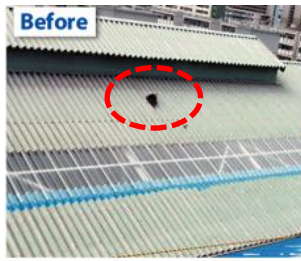
穴も塞ぎ、補修・補強
